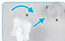
Ligar a mangueira de abastecimento de água à válvula de entrada de água e a uma torneira de água com água fria como indicado.
